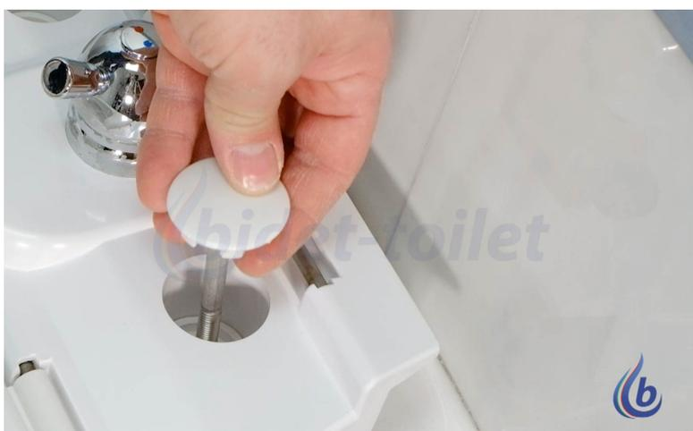
9. Inserire le rondelle di centratura nelle viti di fissaggio e avvitare i dadi fino a far presa sul sanitario wc (con l'utilizzo della chiavetta *bidet-toilet* è semplicissimo)
