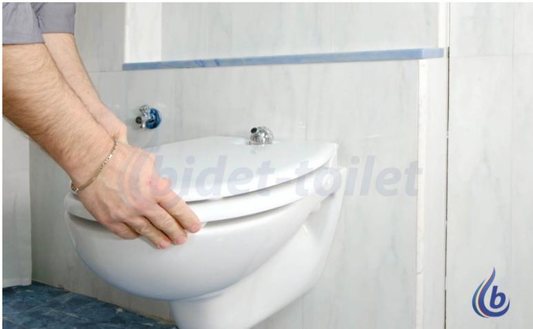
3. Smontare il coperchio della tavoletta *bidet-toilet*, agendo manualmente su le cerniere per staccarlo, così da facilitarne il fissaggio e la centratura
