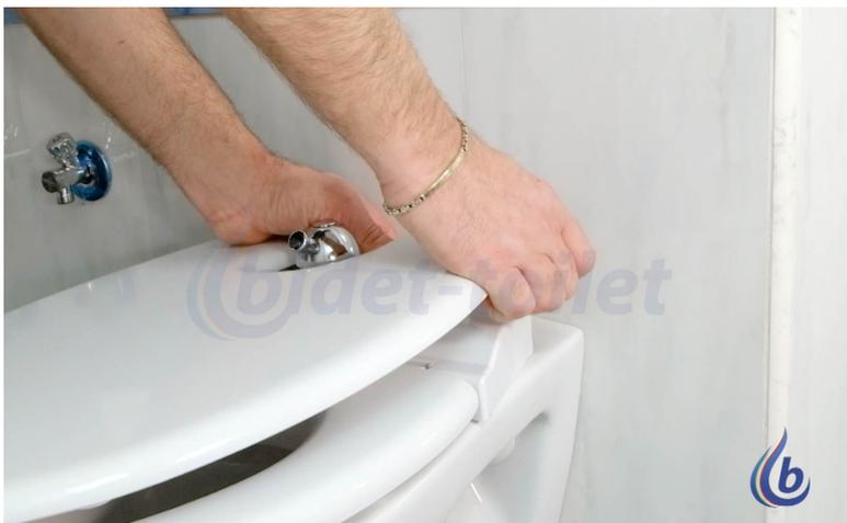
4. Inserire le guarnizioni per i fori di fissaggio sulla base della tavoletta *bidet-toilet*
