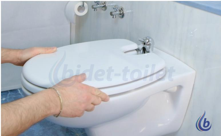
**3.** Controllare che le cerniere di fissaggio della tavoletta *bidet-toilet* siano centrate sui fori di fissaggio del sanitario wc
