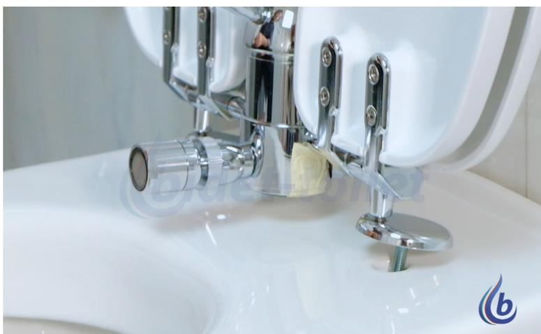
8. Trovata la giusta posizione delle cerniere di fissaggio stringere bene le viti di regolazione per fissare la posizione
