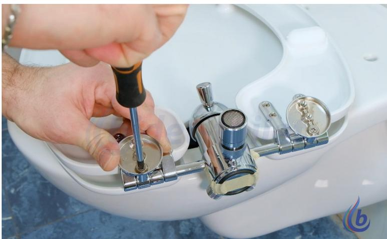
6. Scegliere uno dei due fori per il fissaggio delle barre filettate (in base alla centratura sui fori del sanitario wc) e avvitarle
