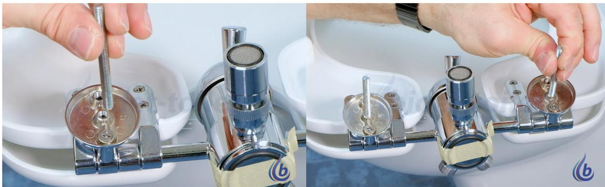
7. Inserire le barre filettate delle cerniere di fissaggio sui fori del sanitario wc e segnare la posizione corretta per centrare la tavoletta *bidet-toilet* sul sanitario wc
